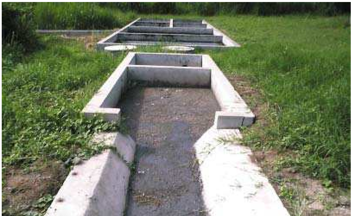
บ่อบำบัดน้ำเสีย
